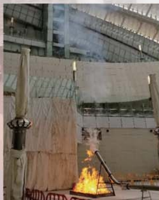
在西九龍站中庭進行熱煙測試。
